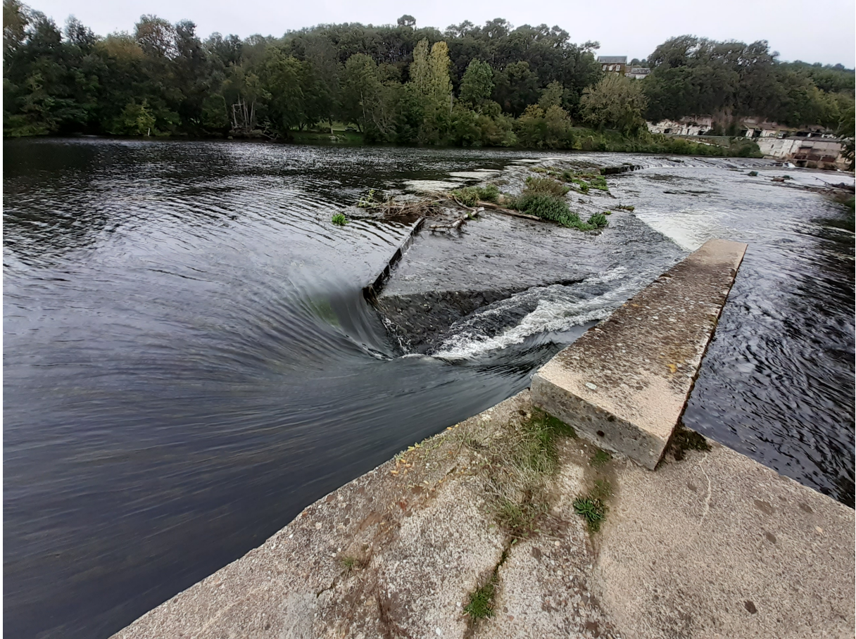
Figure 8 : échancrure de dévalaison en rive droite
