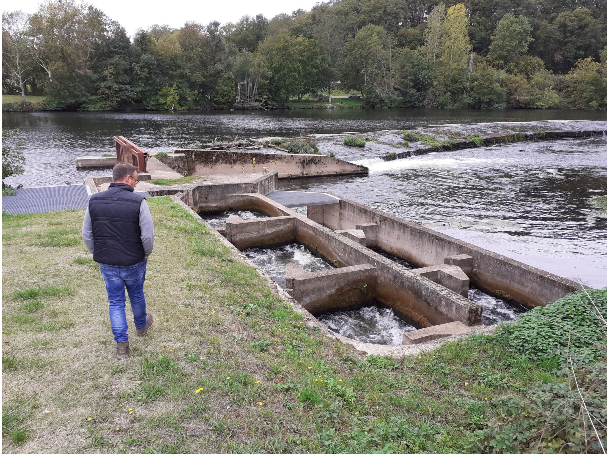
Figure 7 : passe à poissons en rive droite
