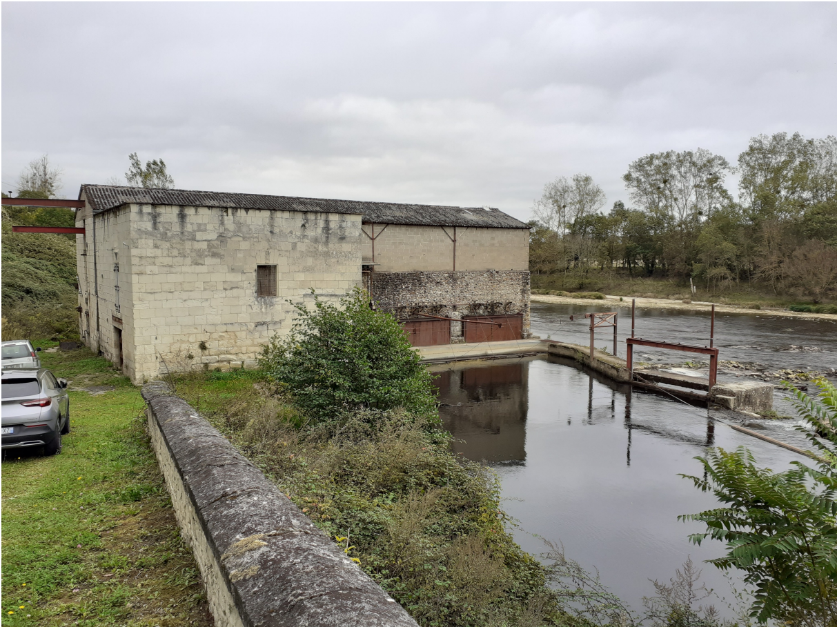
Figure 1 : bâtiment du moulin Gatineau
