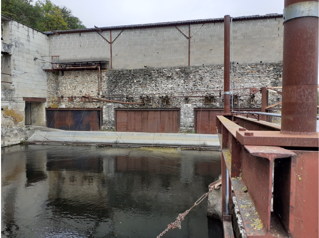
Figure 3 : vue de la prise d'eau
